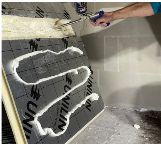
Obr. 3: Lepení PIR desky k podkladu
