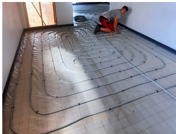
Obr. 4: Pokládka podlahového topení na separační fólii.
