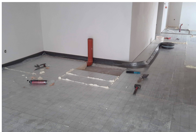
Obr. 1: Doplnění spár a pokládka dilatační pásy.
